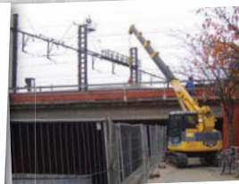
Travaux de levage variés
